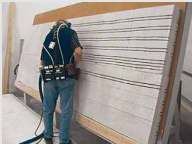
Cięcie bruzd z systemem odsysania Bosch
