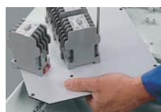
Montaż aparatury na płycie montażowej
