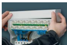
Estetyczny montaż dzięki zastosowaniu osłony na wyprowadzane kable
