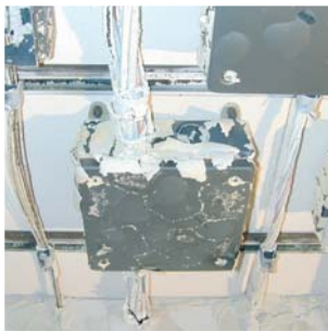
Puszka z podłączonymi kablami po przeprowadzonym teście ogniowym
