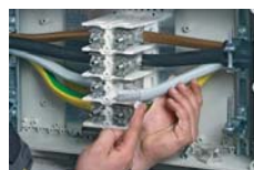
Pokrycie końcówki przewodu wazeliną techniczną
