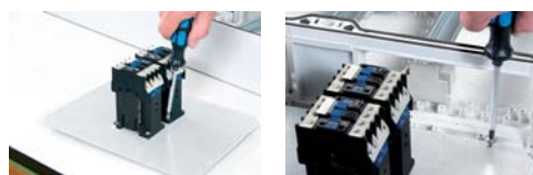
Styczniki na płycie montażowej
