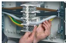
Pokrycie końcówki przewodu wazeliną techniczną
