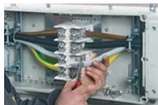
Zeskrobanie warstwy tlenku aluminium z odizolowanej końcówki przewodu
