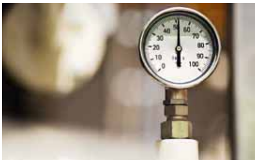
LOCTITE 243 zabezpiecza i uszczelnia gwinty śruby termometru w rurze do transportu oleju pod ciśnieniem.
