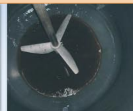
Po 24 godzinach zbiornik był gotowy do napełnienia
