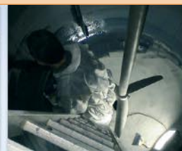
Cały zbiornik pokryty podwójną warstwą produktu Loctite 7227
