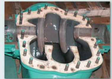
Cała zniszczona powierzchnia została odbudowana
