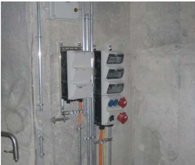
ÖBB (Österreichische Bundesbahn), Lainzer Tunnel, Wien, Österreich
